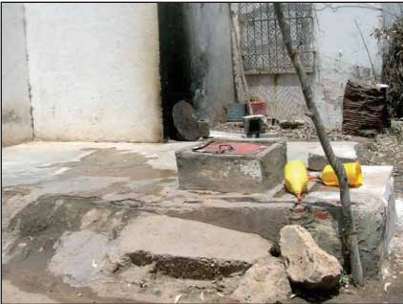
الصورة رقم 16 خزان الماء بمقبرة «بوديس» (آسفي)
